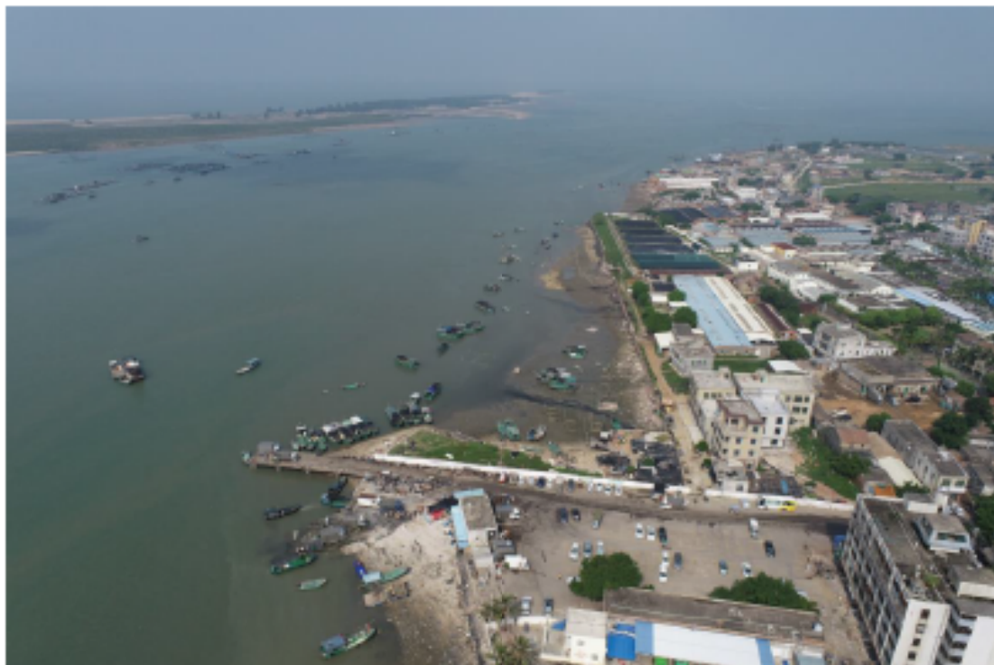
图 2.12.1-3 湛江东海岛东南渔港项目一期工程现状照片
